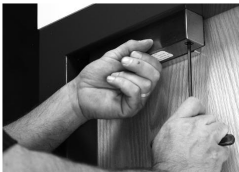
Obrázek 17. Montáž systému Magnalock
