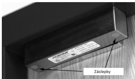
Obrázek 18. Vložení záslepek
