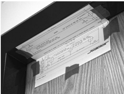
Obrázek 4. Přípevnění šablony
