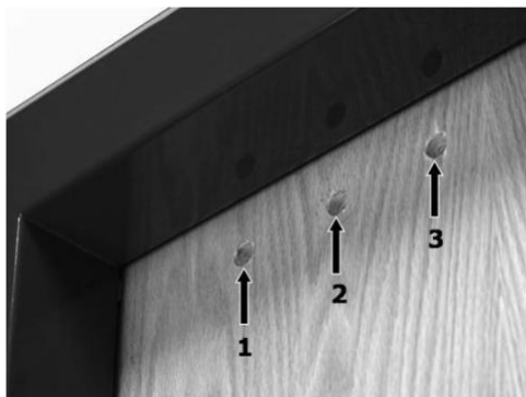
Obrázek 6. Otvory pro přídržnou desku
